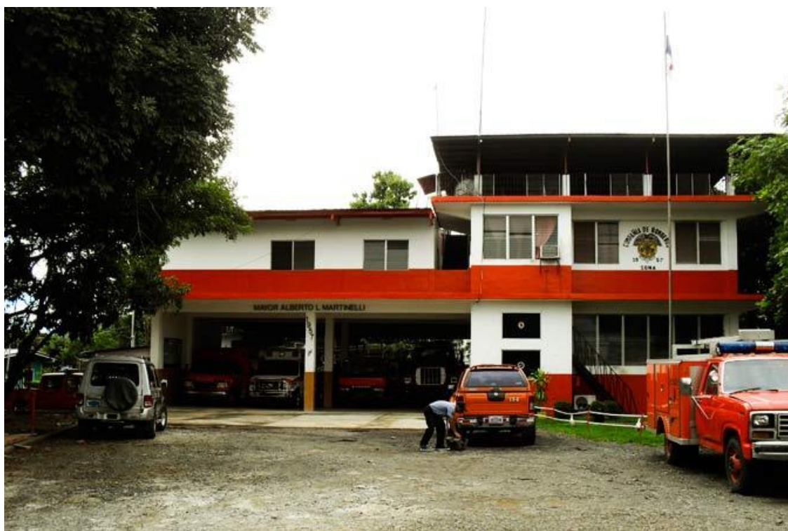
Ilustración 43. Estación de Bomberos (Alberto Martinelli), Ciudad de Soná.
