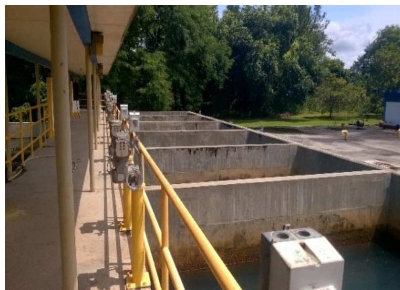
Figura Vista actual de la planta potabilizadora y de los filtros de arena Fuente IDAAN.
