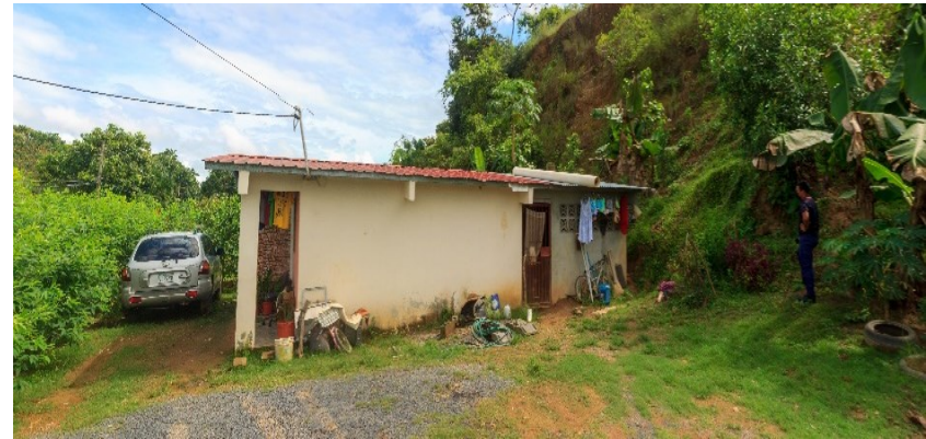
Figura 13 Casas en Foresta A y B con riesgo de deslizamiento. Fuente: Equipo consultor
