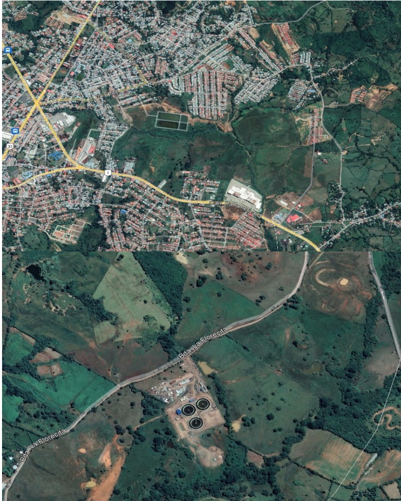
Figura 20 Vista satelital de las Lagunas de oxidación y la Nueva PTAR en construcción. Fuente: Google Earth
