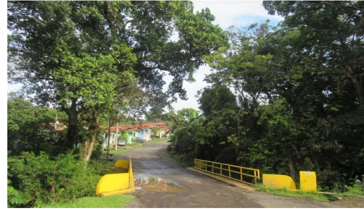
Figura 65 Puente sobre el río San Juan. Fuente: elaborado por el equipo consultor
